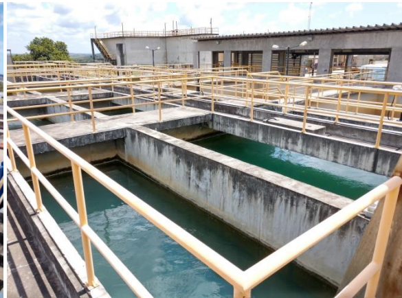
Figura 2- Ampliação da ETA João Ednaldo
